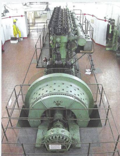
Der 1000-PS- Diesel aus dem Jahr 1935 im Maschinensaal
