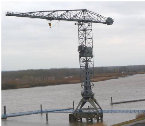
Bewaarde kraan van de Boelwerf Foto's A.B.
