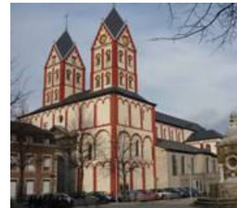
St.-Bartholomeuskerk Foto A.B.
