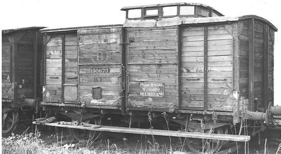
Fig. 8.29 Wagen 190.673, gelijkaardig aan wagen van fig.8.27, doch zonder verhoogde remkabine. Bouw: ± 1890; De uitkijk is wellicht niet origineel. Stond uitgeweken te Luik Val Benoit
