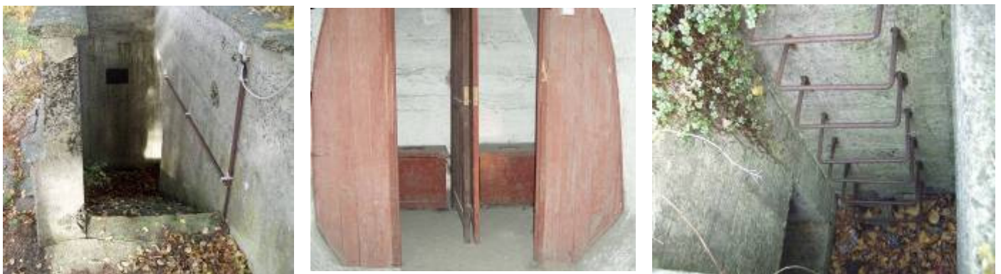
Fig. 10.11 Foto's schuilkelder Foto 1: Toegang schuilkelder.
