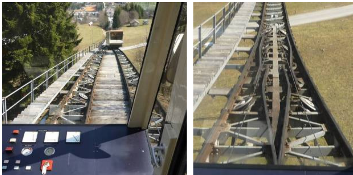
Fig. 16.3 Kruising in het kabelspoor (Funicular) met Abt-wissels in het Oostenrijkse Bad-Hofgastein
